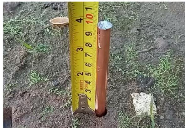
Figura 5 - Instalação de uma das hastes de cobre ao solo.
